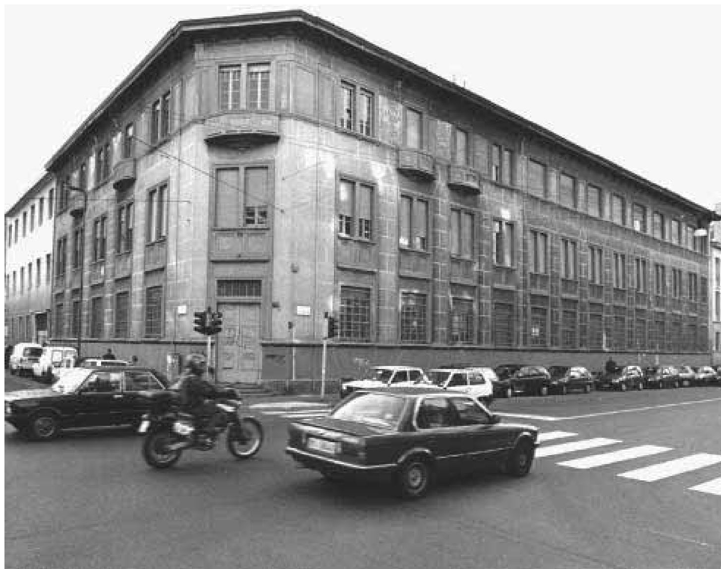
La sede della Telecom in viale Marche 15
