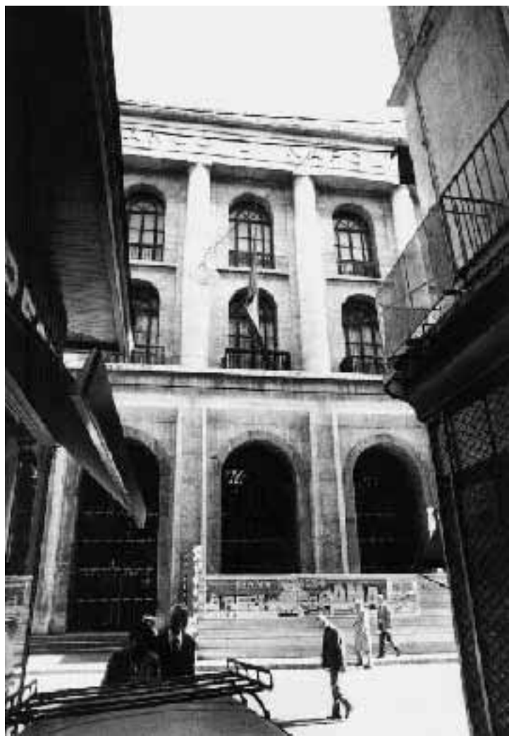
La sede centrale del Banco di Napoli
