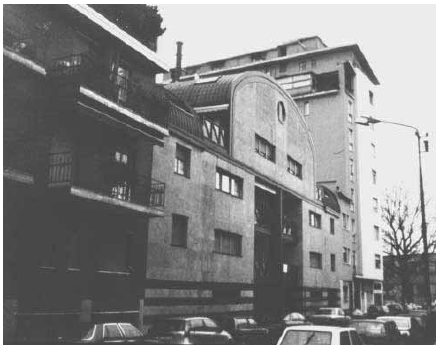
L'edificio realizzato da Giovanni Mistretta in via Armenia
