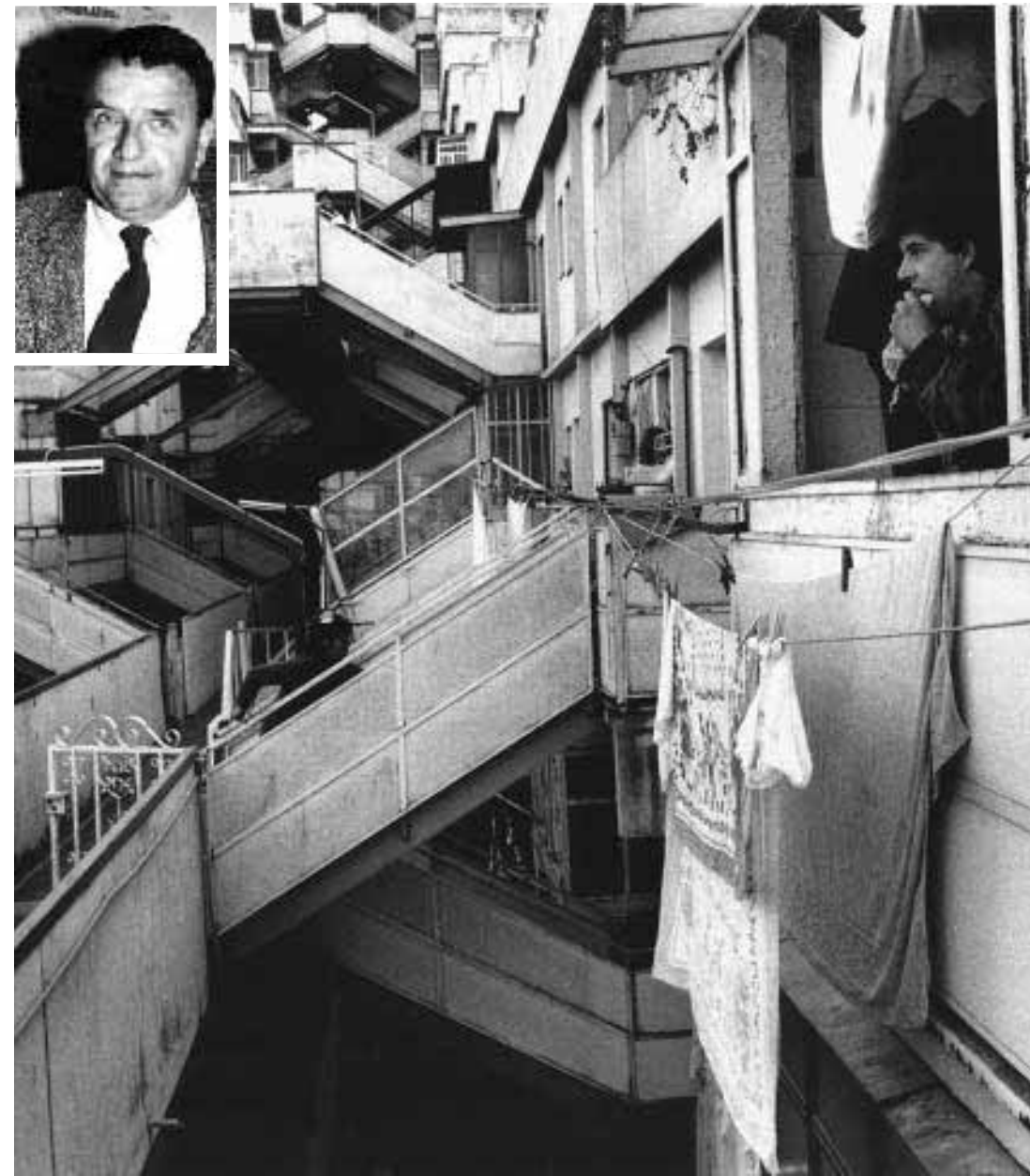
Il complesso «Le Vele» alla periferia di Napoli
