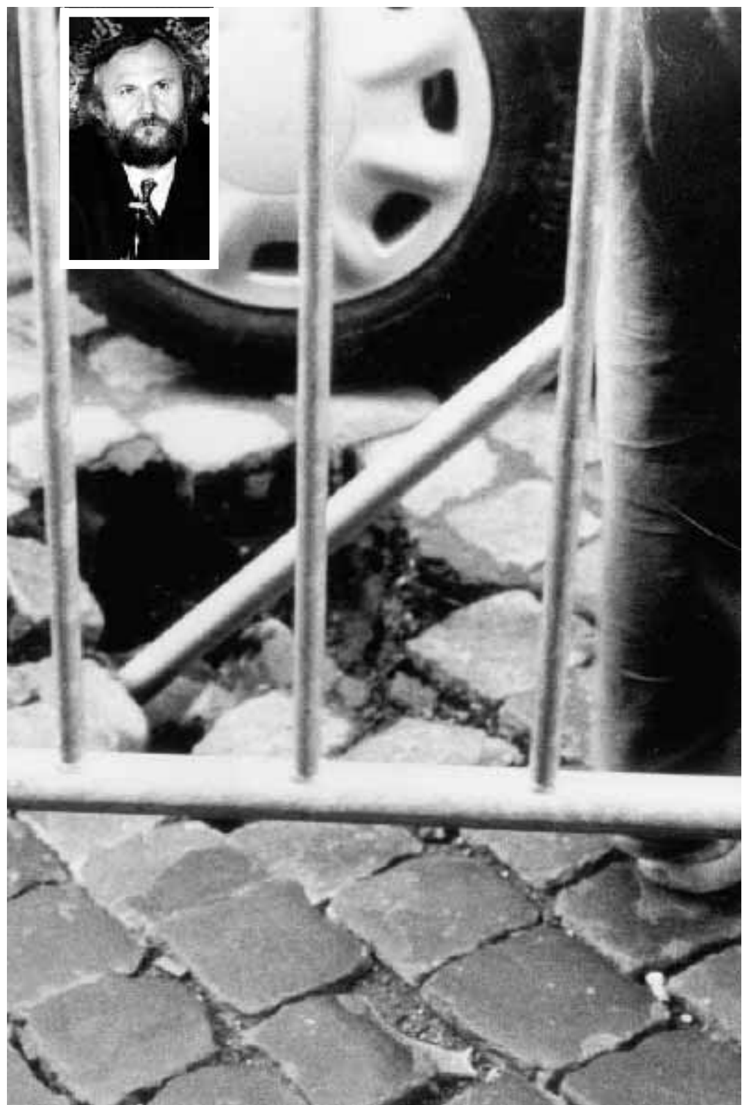
Una buca in riparazione e in alto l'assessore Esterino Montino
