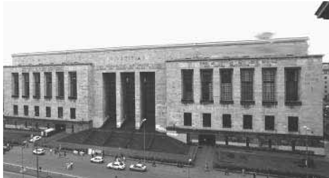
Panoramica sul vecchio Palazzo di Giustizia che ormai al collasso, servono più spazio per nuove aule e uffici Perrucci-De Bellis
