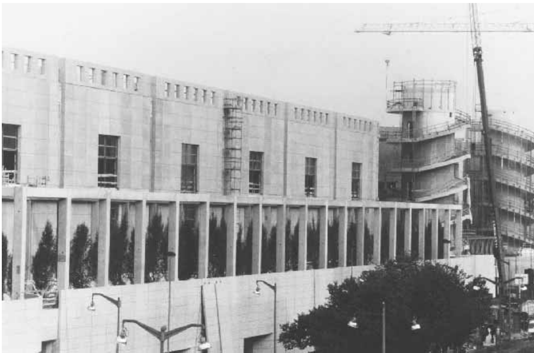
Una panoramica del cantiere al Portello Fiera
