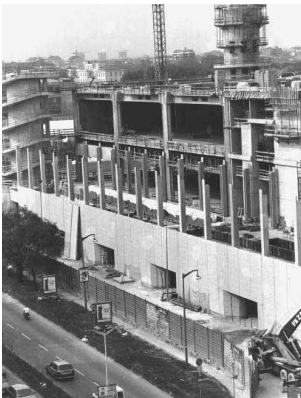
Uno scorcio del cantiere al Portello Fiera
