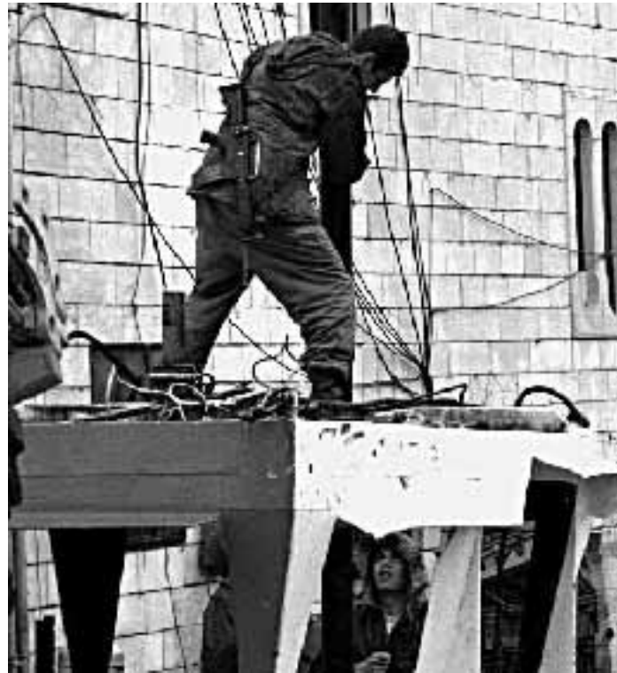
La rimozione di una torre di guardia a Hebron
