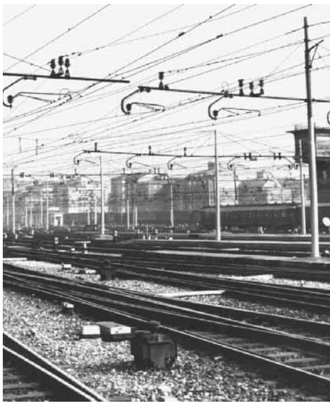
Uno scorcio dei binari alla stazione Centrale
