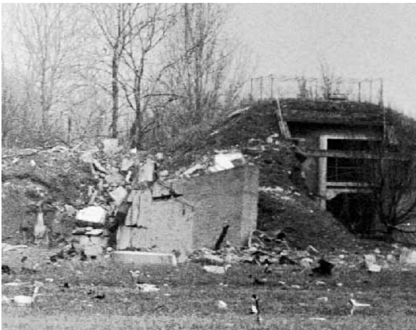
L'esterno del bunker dove viene lavorata la nitroglicerina e dove sono morti in un'esplosione due operai
