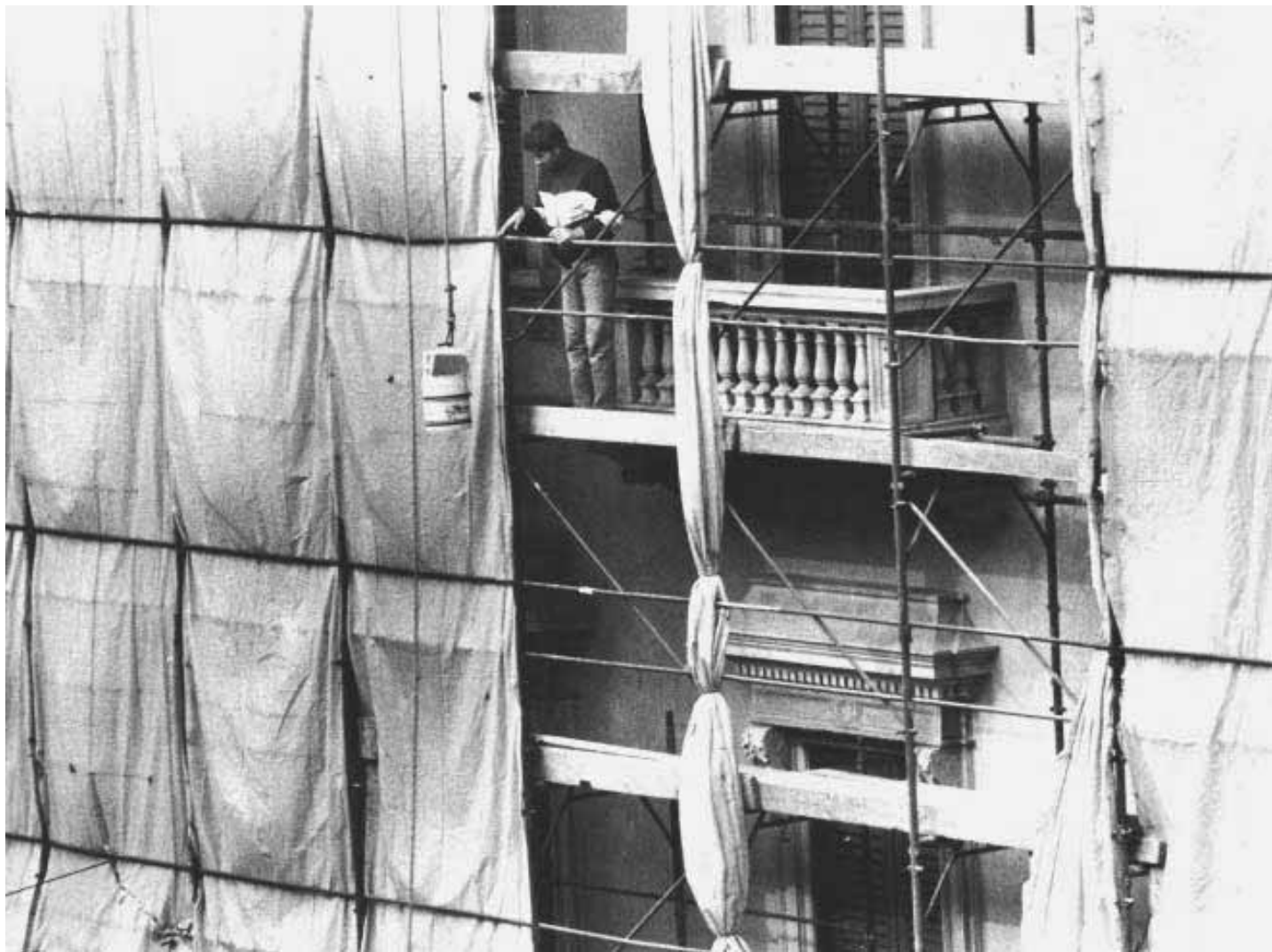
Un cantiere edile
