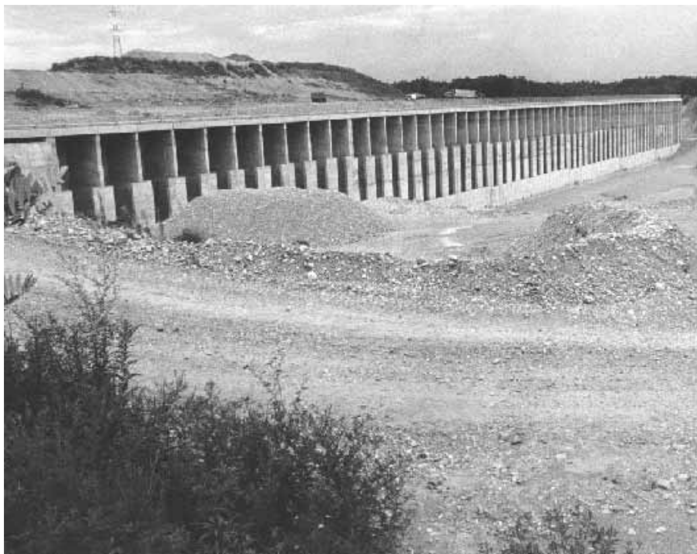
Il grande muro della discarica di Cerro al centro delle polemiche
