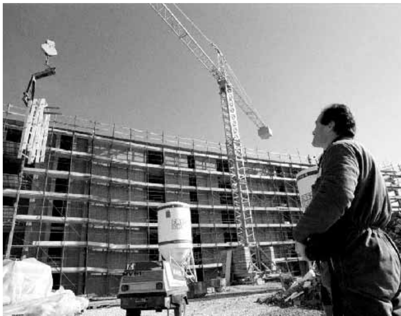
Un operaio edile osserva un palazzo in costruzione
