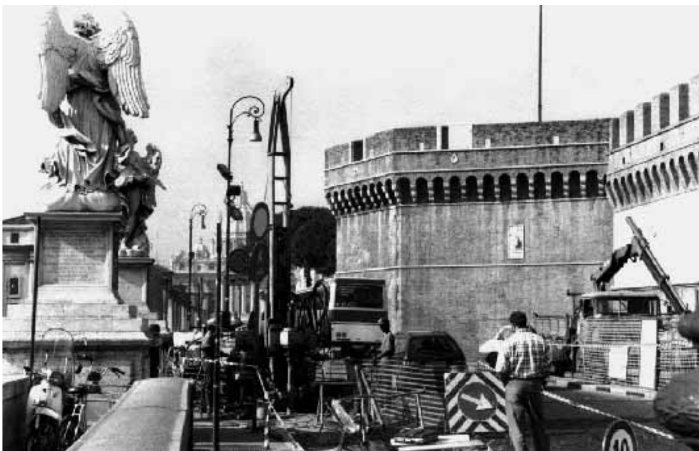
I sondaggi effettuati davanti a Castel Sant'Angelo per il sottopasso sul Lungotevere
