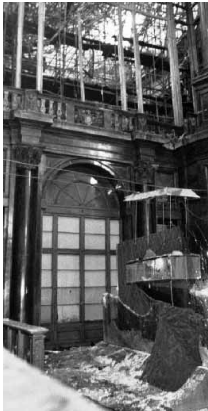
L'interno del Duomo di Torino devastato dopo l'incendio
