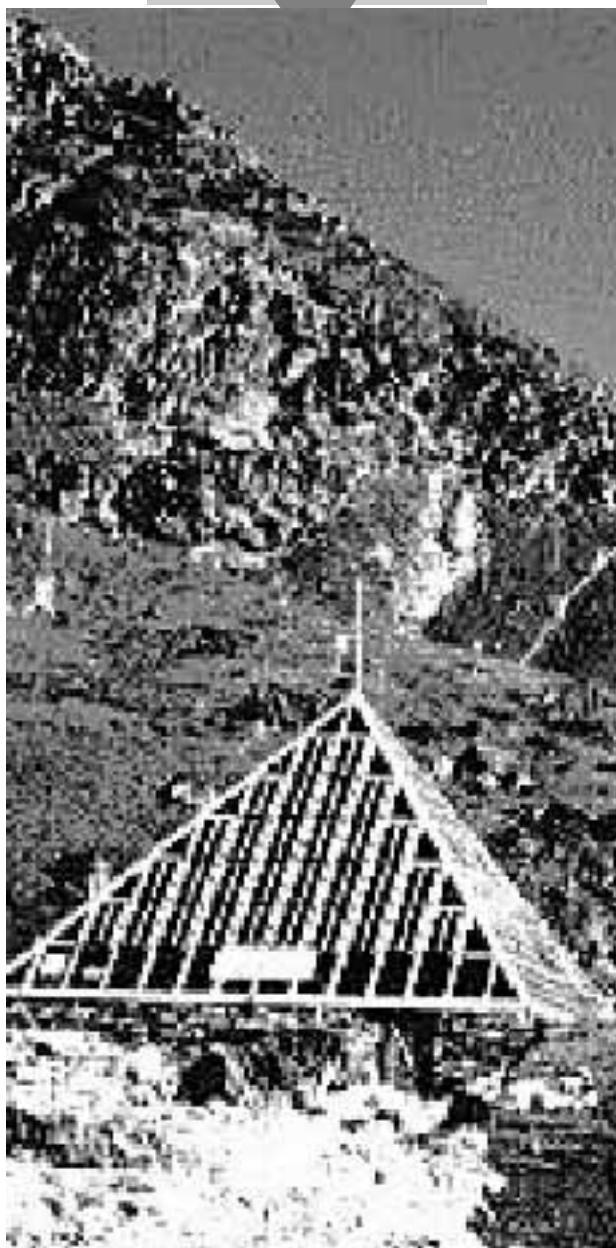
È iniziata la spedizione del Cnr sull'Everest, chiamata «East-Lhotse». Si tratta di una missione che si avrà per base la piramide di vetro e alluminio (nella foto) costruita a quota 5.000 metri sull'Everest e un secondo campo costruito a 6.400 metri di quota proprio sotto la parete est della più grande montagna del mondo. Si studieranno gli effetti dell'alta quota sull'organismo di alcuni alpinisti. La missione sarà collegata in teleconferenza via satellite con una decina di scuole italiane. Ieri si è collegata una quinta elementare che ha dialogato a lungo con i protagonisti dell'impresa. L'iniziativa si svolge all'interno del più vasto progetto «Ev-K2-Cnr».
