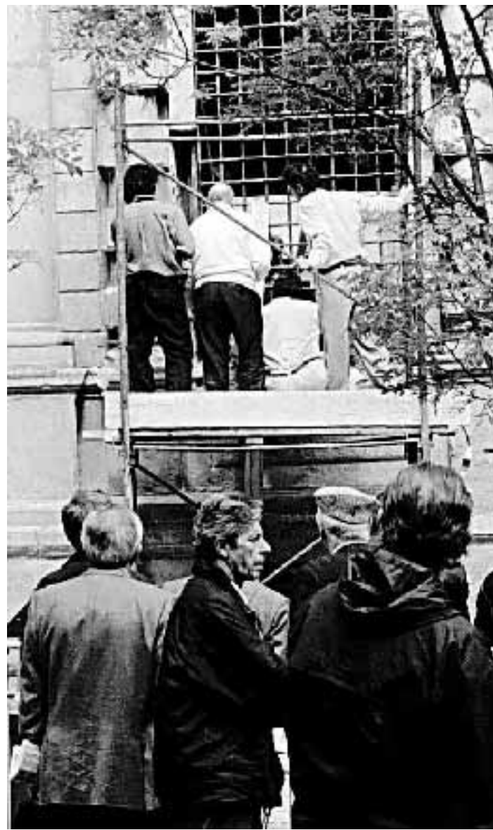
Curiosi osservano gli operai intenti a riparare i danni dell'esplosione. Farinacci/Ansa
