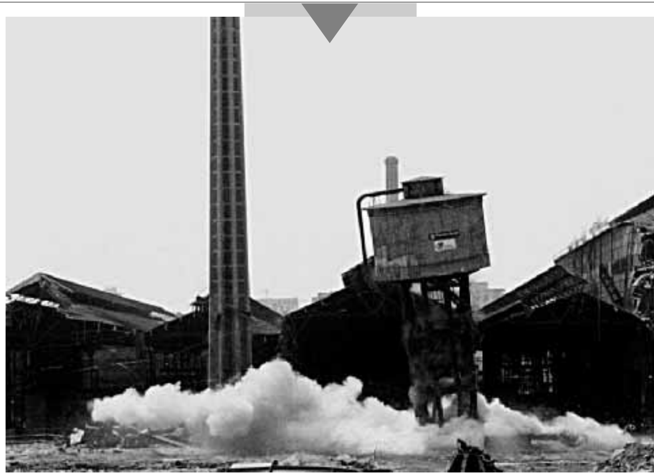
TORINO. Un momento dell'«implosione» delle ex Ferriere Fiat di Torino. La vecchia fabbrica viene demolita per costruire nel prossimo futuro un parco tecnologico.
