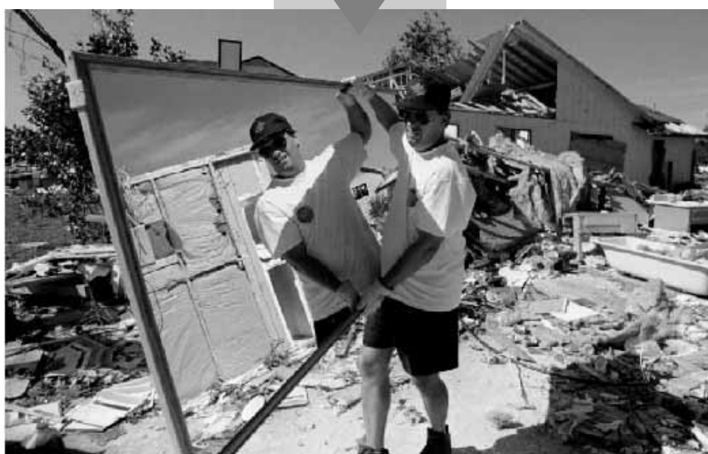
JARRELL, Texas. Jim Miller porta uno specchio fuori dalla sua casa in Cedar Park distrutta dal tornado. Più di duecento costruzioni sono state danneggiate dai tornadi e dalle raffiche di vento che si sono abbattute sull'exas centrale. I danni sono stati valutati tra i 25 e 50 milioni di dollari.
