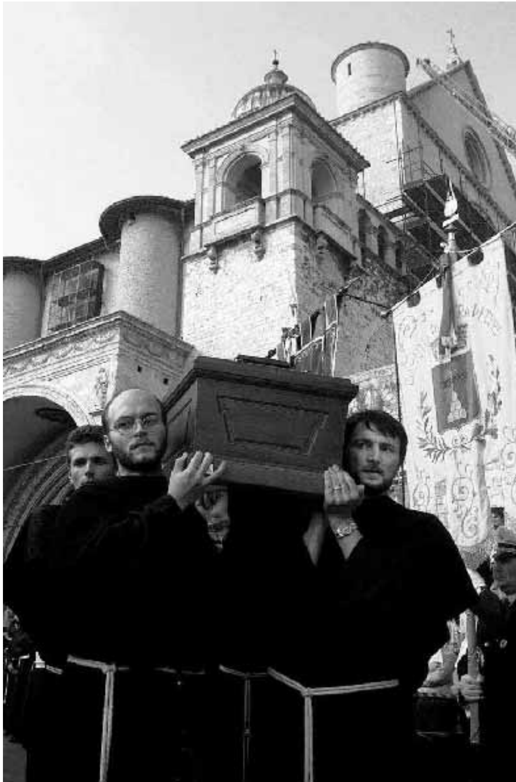
I funerali dei frati morti durante il crollo della volta della Basilica di San Francesco
