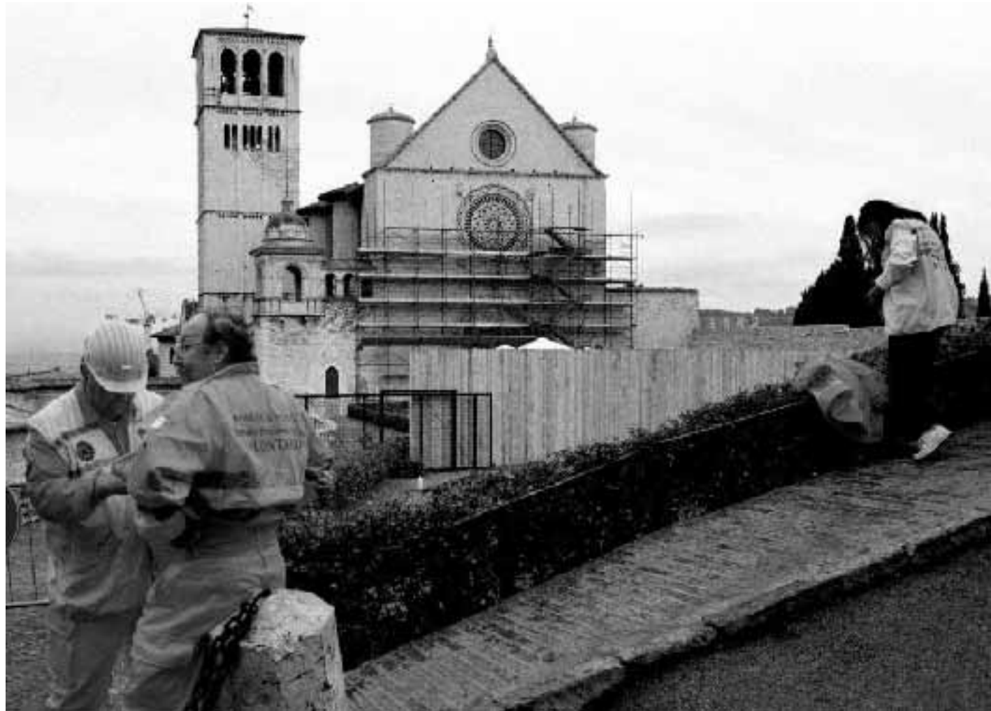
Ancora crolli alla Basilica di San Francesco ad Assisi
