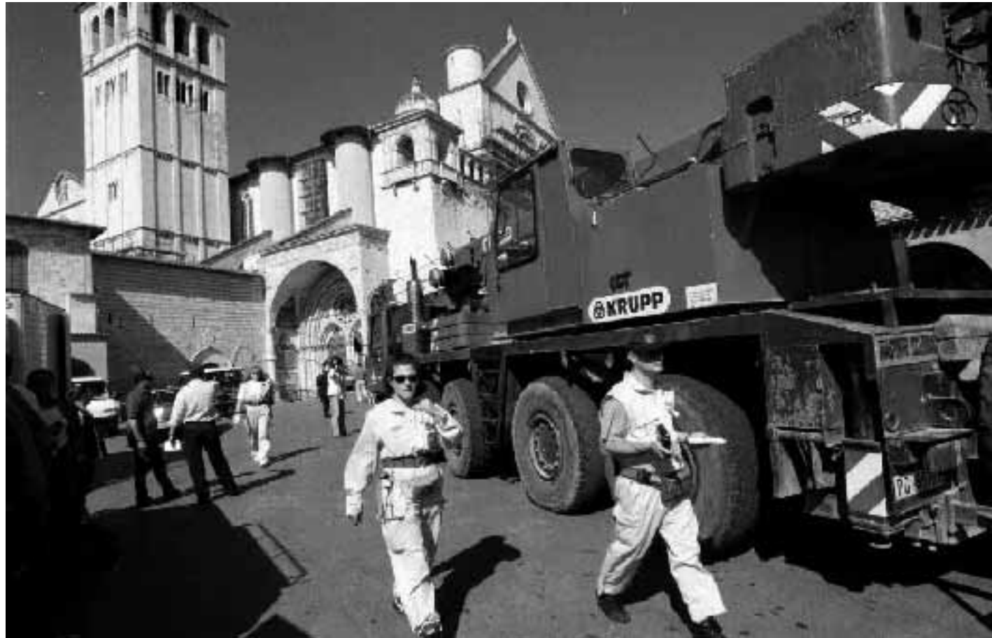
La gru che servirà per l'intervento sul timpano del transetto della chiesa sul piazzale inferiore della basilica
