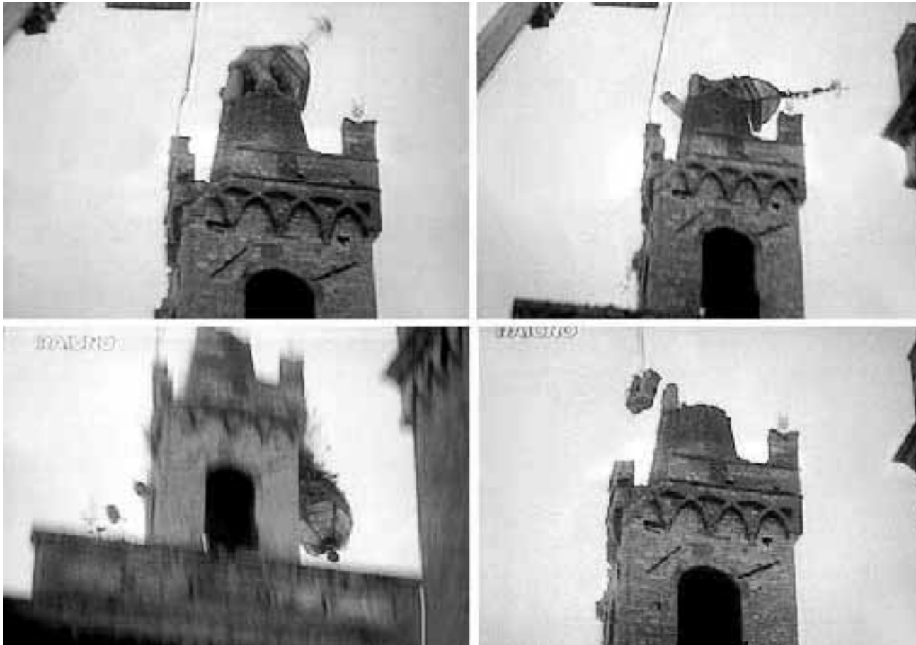
Quattro immagini, riprese dalla tv, delle fasi del crollo del torrino della torre civica del palazzo comunale di Foligno Ansa
