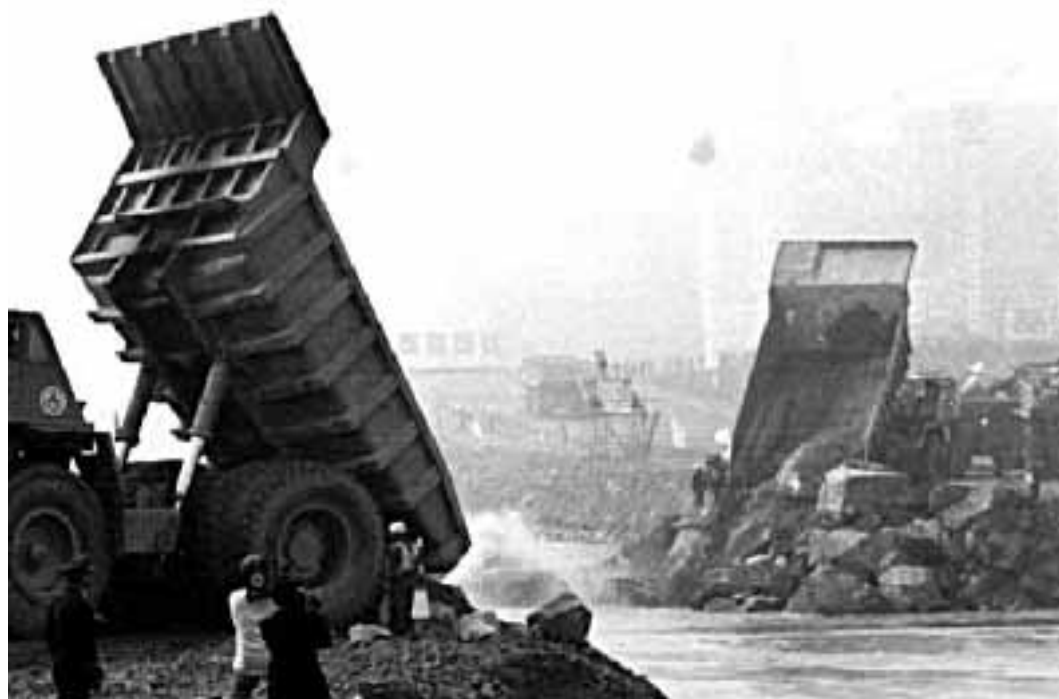
I camion scaricano nelle acque dello Yangtze gli ultimi massi per imbrigliare il fiume
