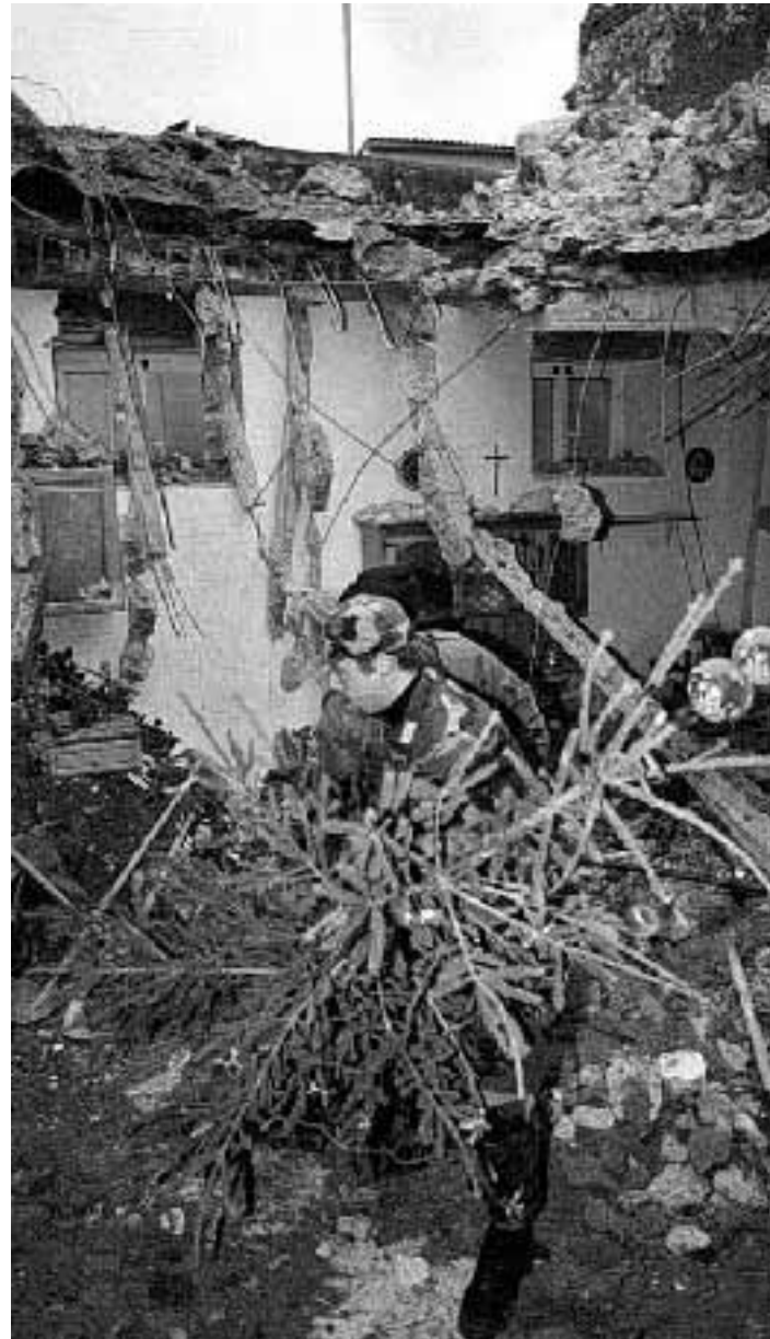
La casa di Lettere su cui si è abbattuto un muro di cinta Fusco/Ansa
