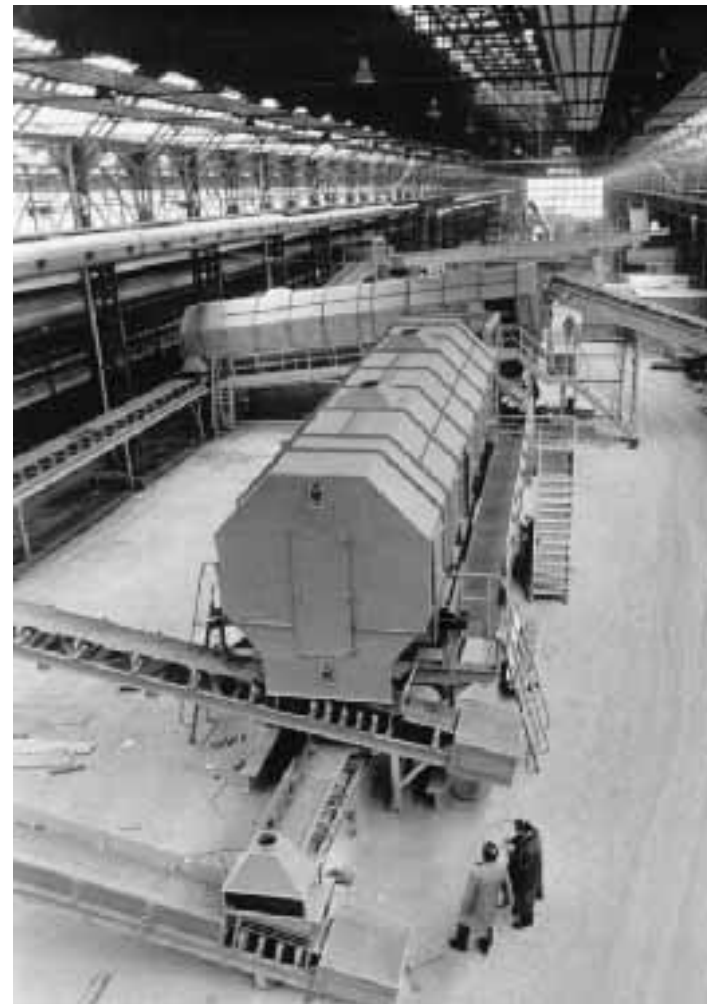
L'impianto di trattamento dei rifiuti all'ex Maserati
