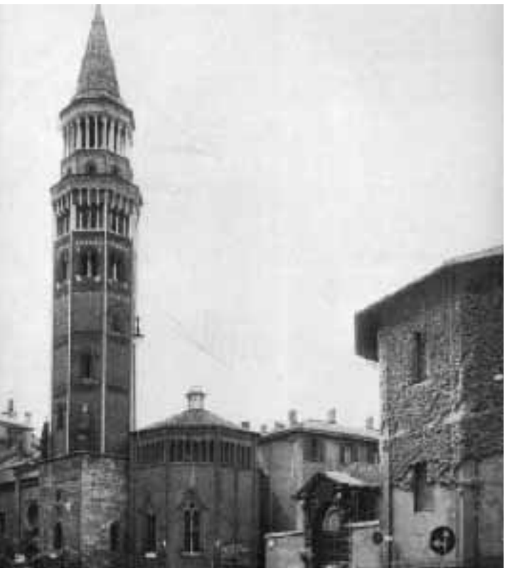
Il campanile di San Gottardo
