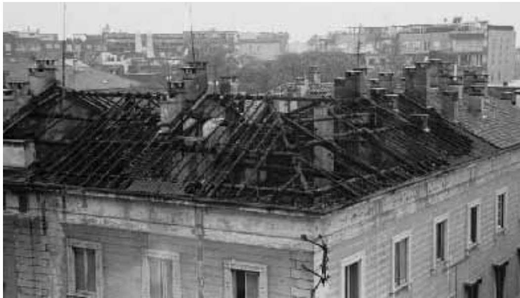
Il tetto completamente bruciato dell'edificio in corso di Porta Romana
