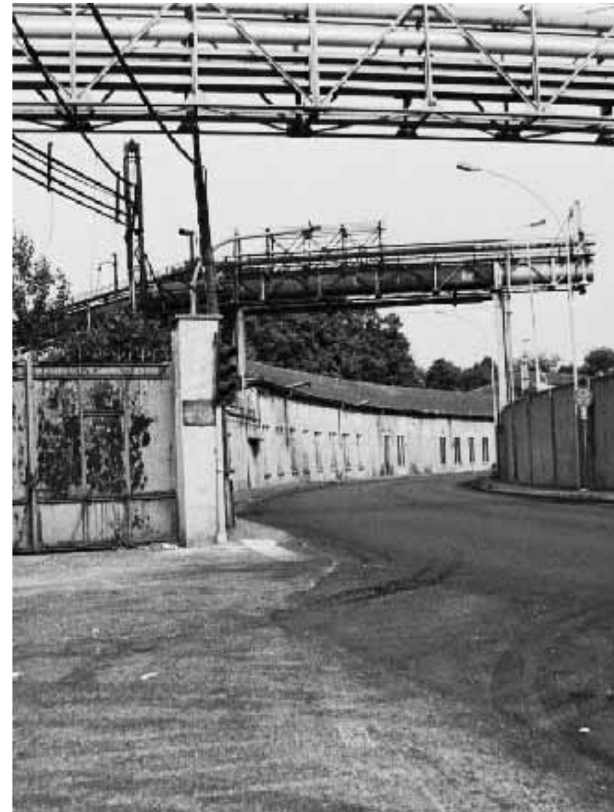
Un capannone della ex Falck Vulcano, che verrà interamente trasformata
