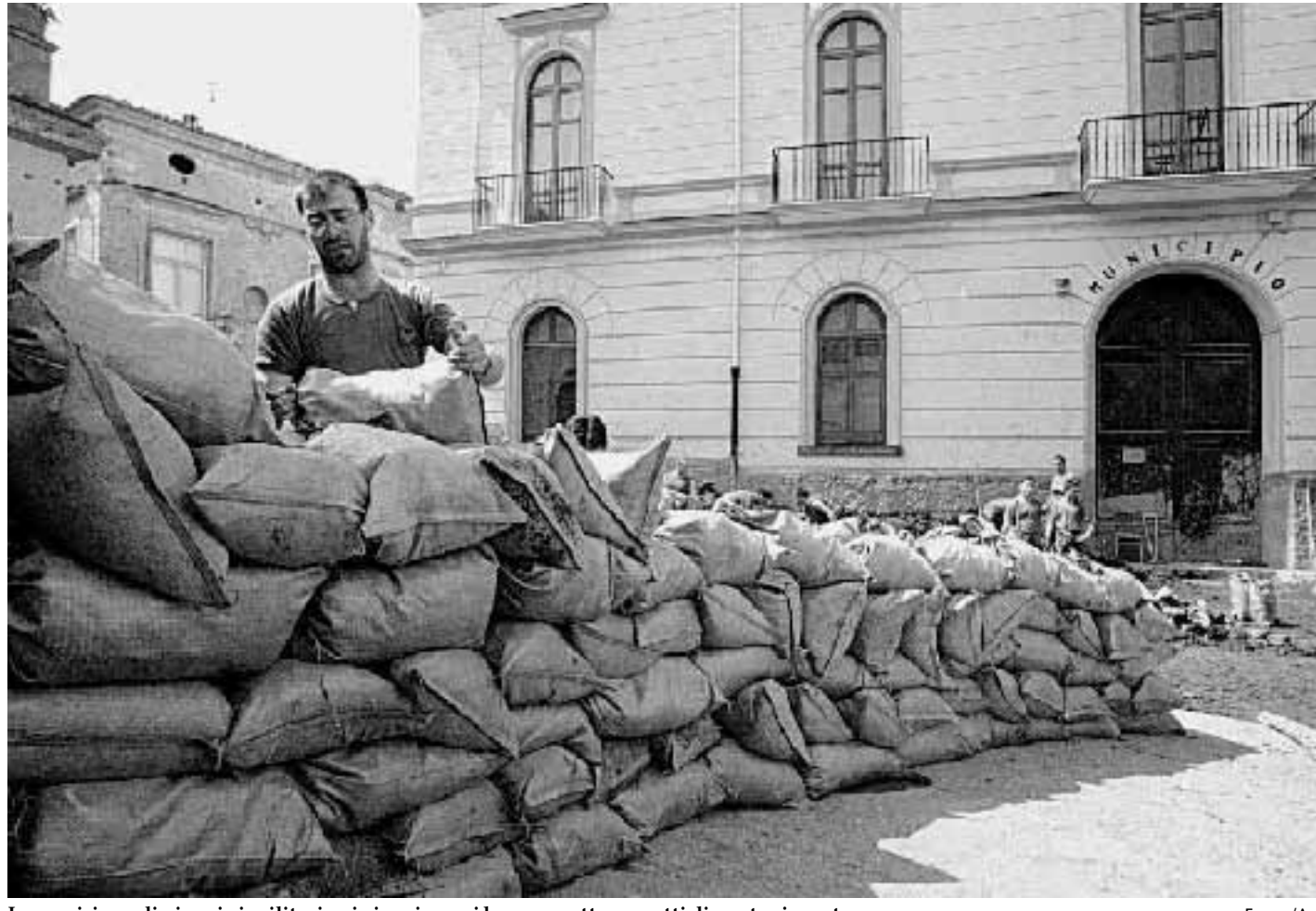
In previsione di pioggia i militari nei giorni scorsi hanno eretto muretti di contenimento
