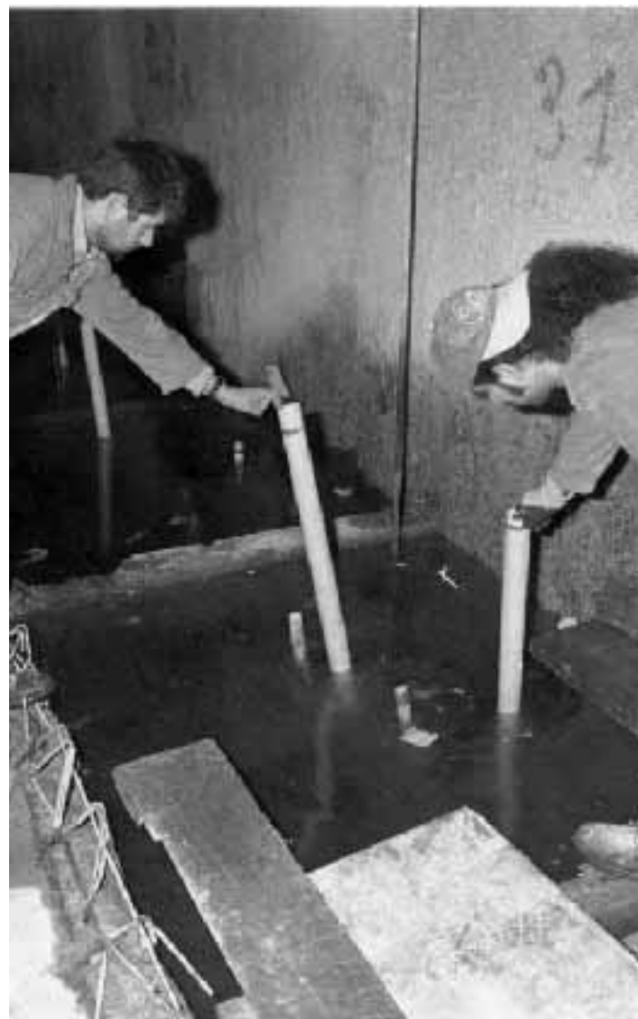
Controlli per misurare l'innalzamento della falda
