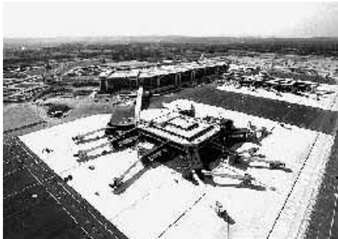
Il cantiere dell'aeroporto Malpensa 2000
