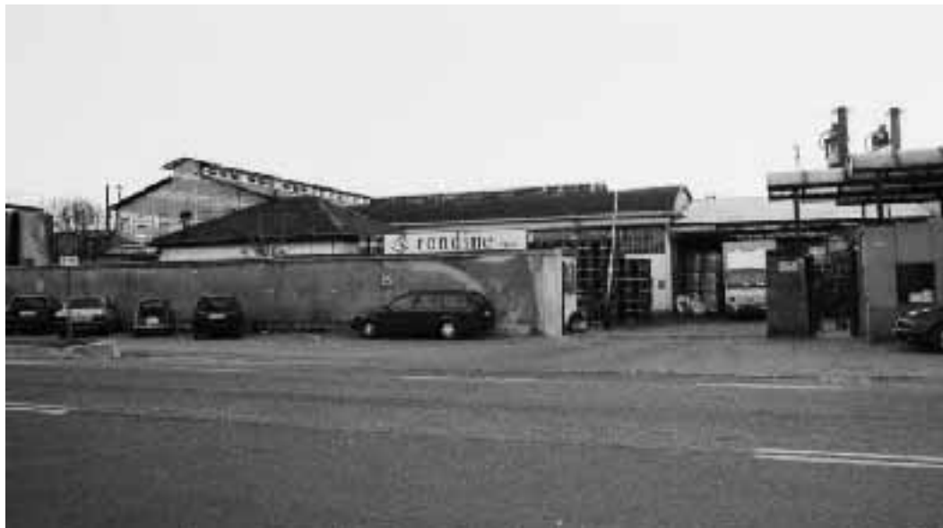
L'ingresso all'area dismessa delle ex raffinerie di Pero
