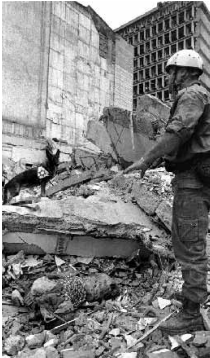
Si continua a scavare tra le macerie
