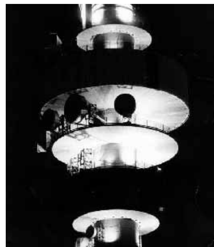
Un particolare dell'antenna Telecom a Roma
