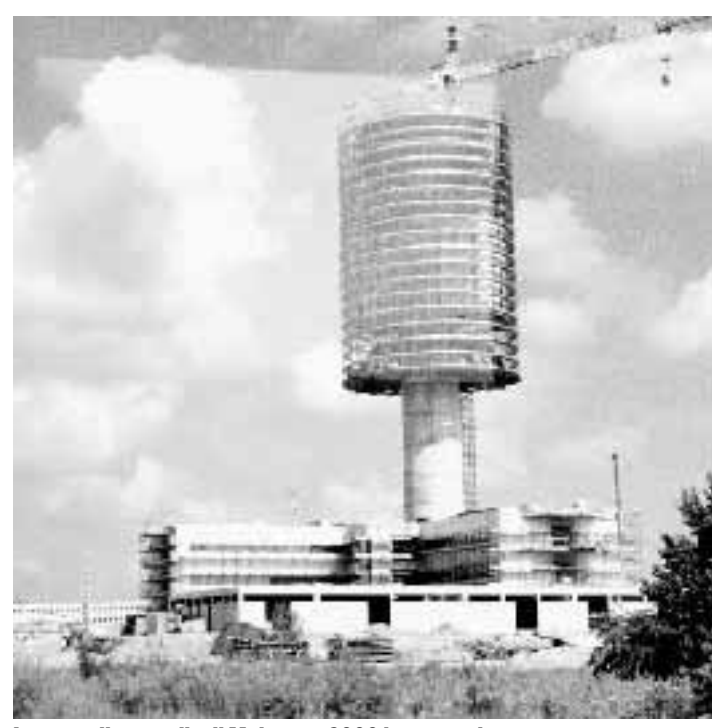
La torre di controllo di Malpensa 2000 in costruzione Dal Zennaro/Ansa
