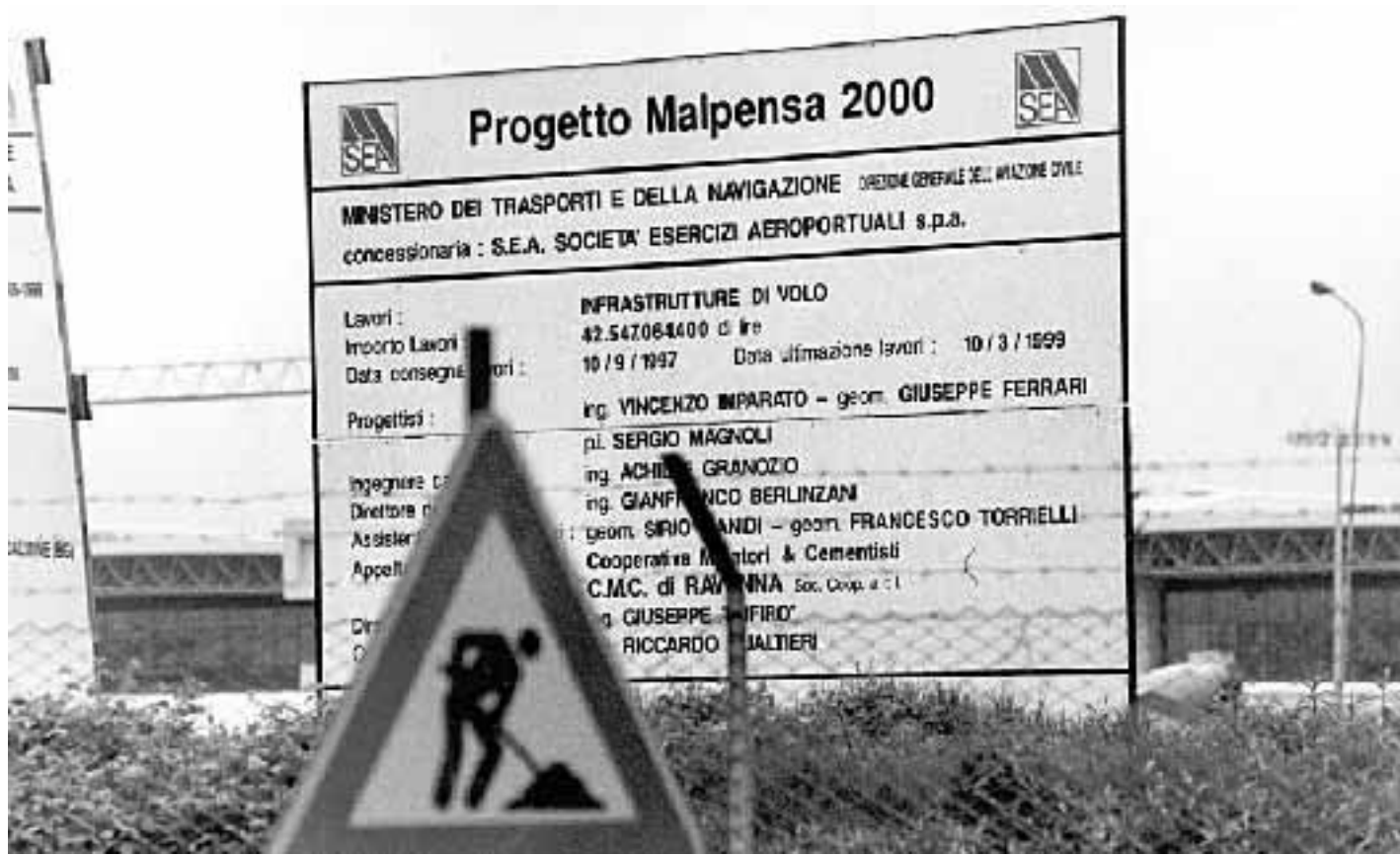
Il cantiere del nuovo aeroporto «Malpensa 2000»
