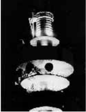
L'antenna Telecom a Roma
