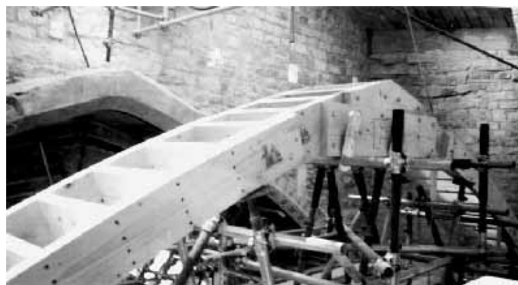
La centina in legno per la ricostruzione della volta crollata nella basilica di San Francesco. A sinistra, la facciata di Santa Chiara.
