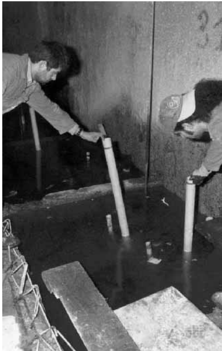
Monitoraggio di un box allagato; in alto, i sotterranei allagati dell'ospedale S. Paolo a Milano
