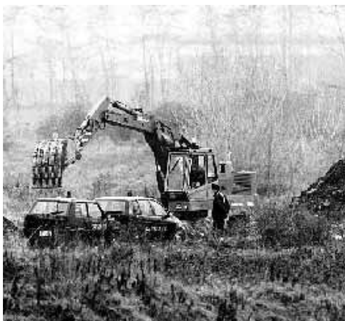
Gli scavi nella zona della ex discarica di Viarolo
