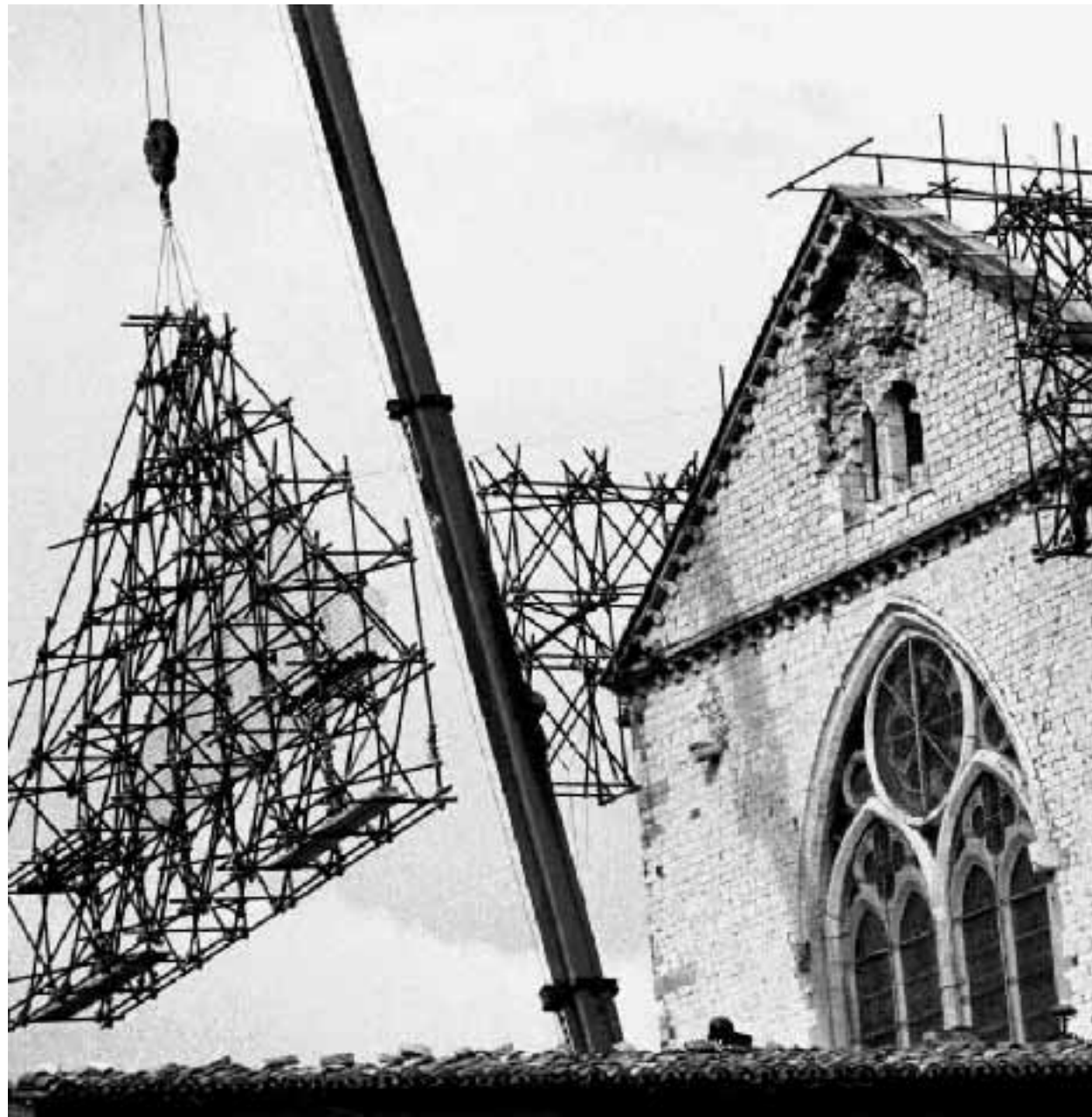
Una fase del restauro di Assisi dopo il terremoto dello scorso anno. Sotto, lo Spedale di Santo Spirito di Firenze
