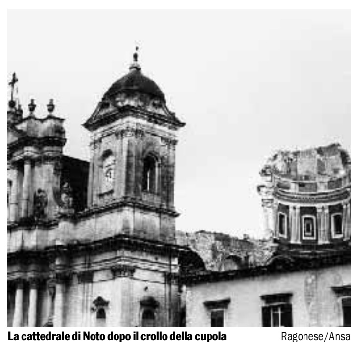
La cattedrale di Noto dopo il crollo della cupola
