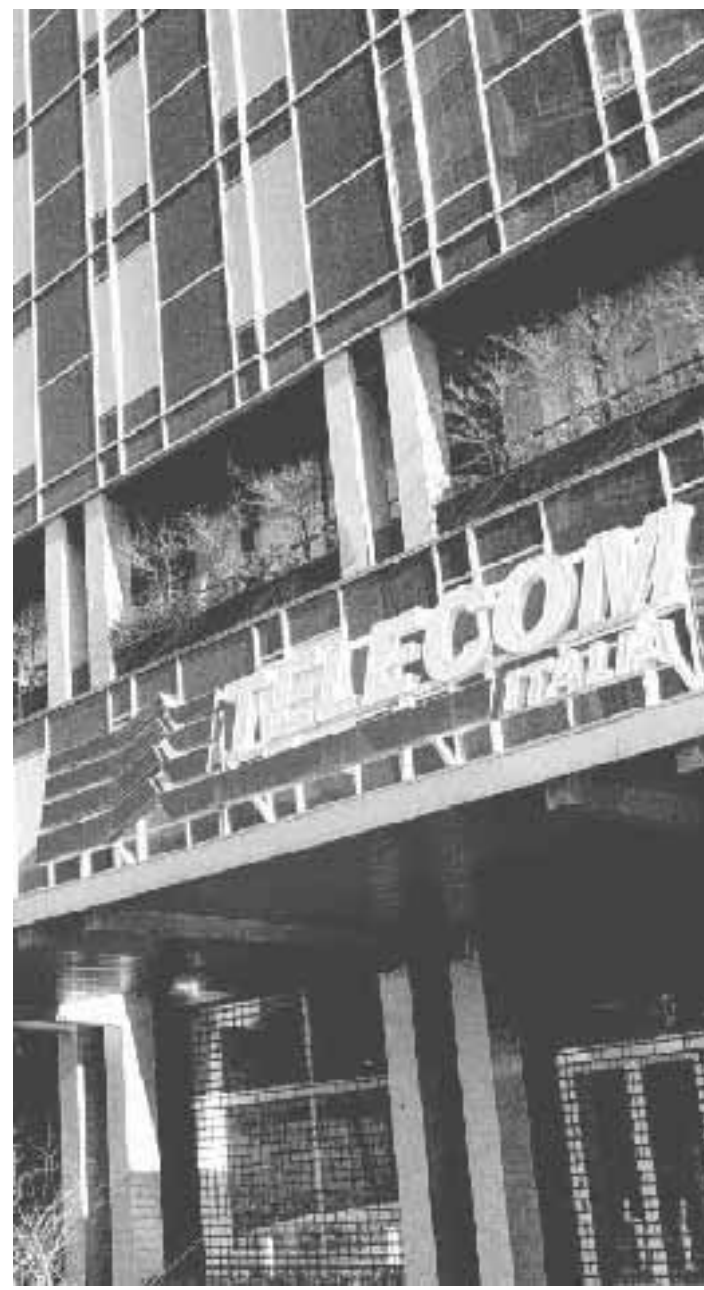
La sede della Telecom Italia a Milano
