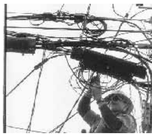
Un operaio al lavoro su un traliccio
