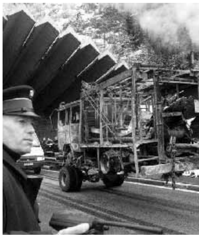
La rimozione delle carcasse dei veicoli bruciati
