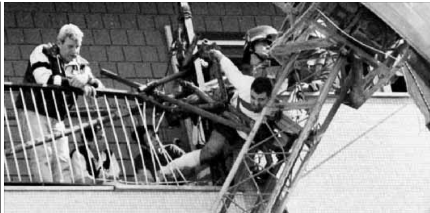
I vigili del fuoco soccorrono l'operaio che è rimasto per due ore e mezzo sospeso in aria, con le gambe incastrate nel ponteggio che aveva ceduto. Ansa
