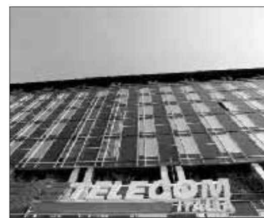
La sede di Telecom Italia a Milano sotto la stazione ferroviaria del capoluogo lombardo
