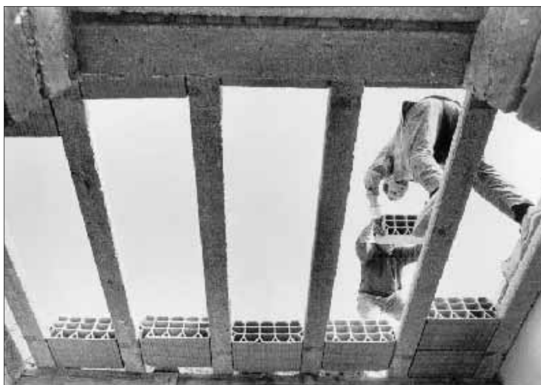
Lavori edili di un edificio
